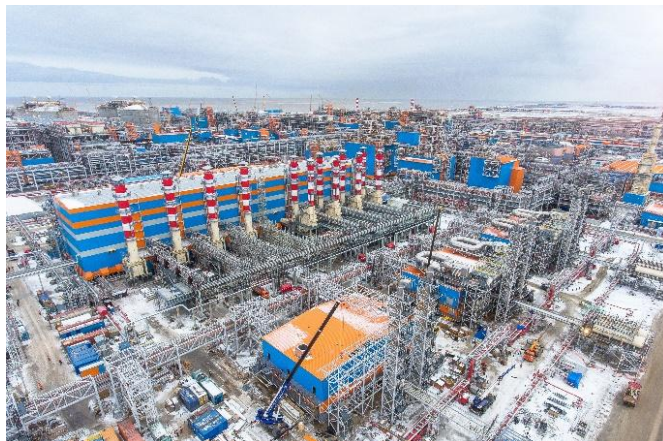
Fig.2 様々なモジュールが現場で据え付けられた写真
